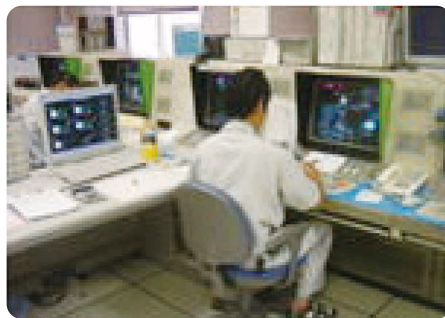
水処理設備監視システム
