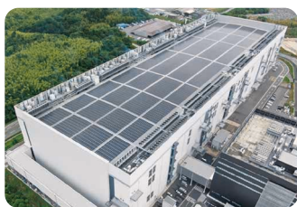
第6製造棟太陽光発電システム
