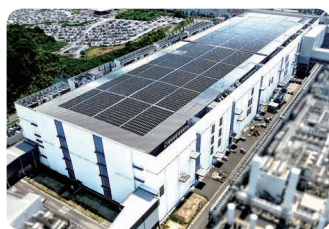
第5製造棟太陽光発電システム
