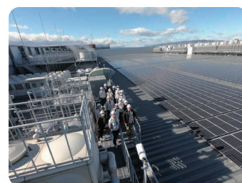
第6製造棟太陽光発電システム
